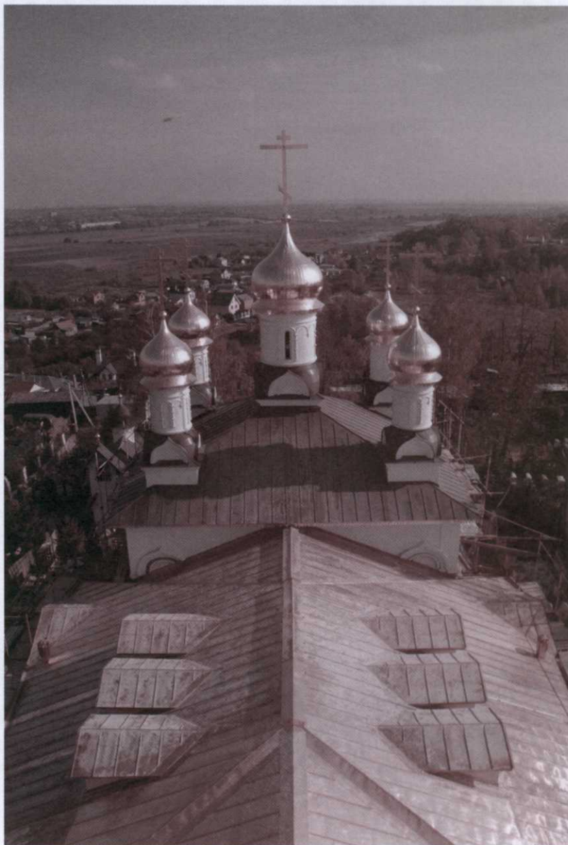
Новая кровля на трапезной части храма Архангела Михаила
