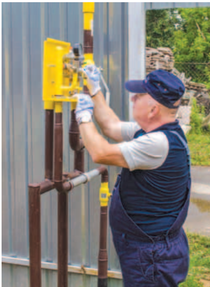
Пуско-наладочные работы на газопроводе среднего давления. 7 июля 2026 года
