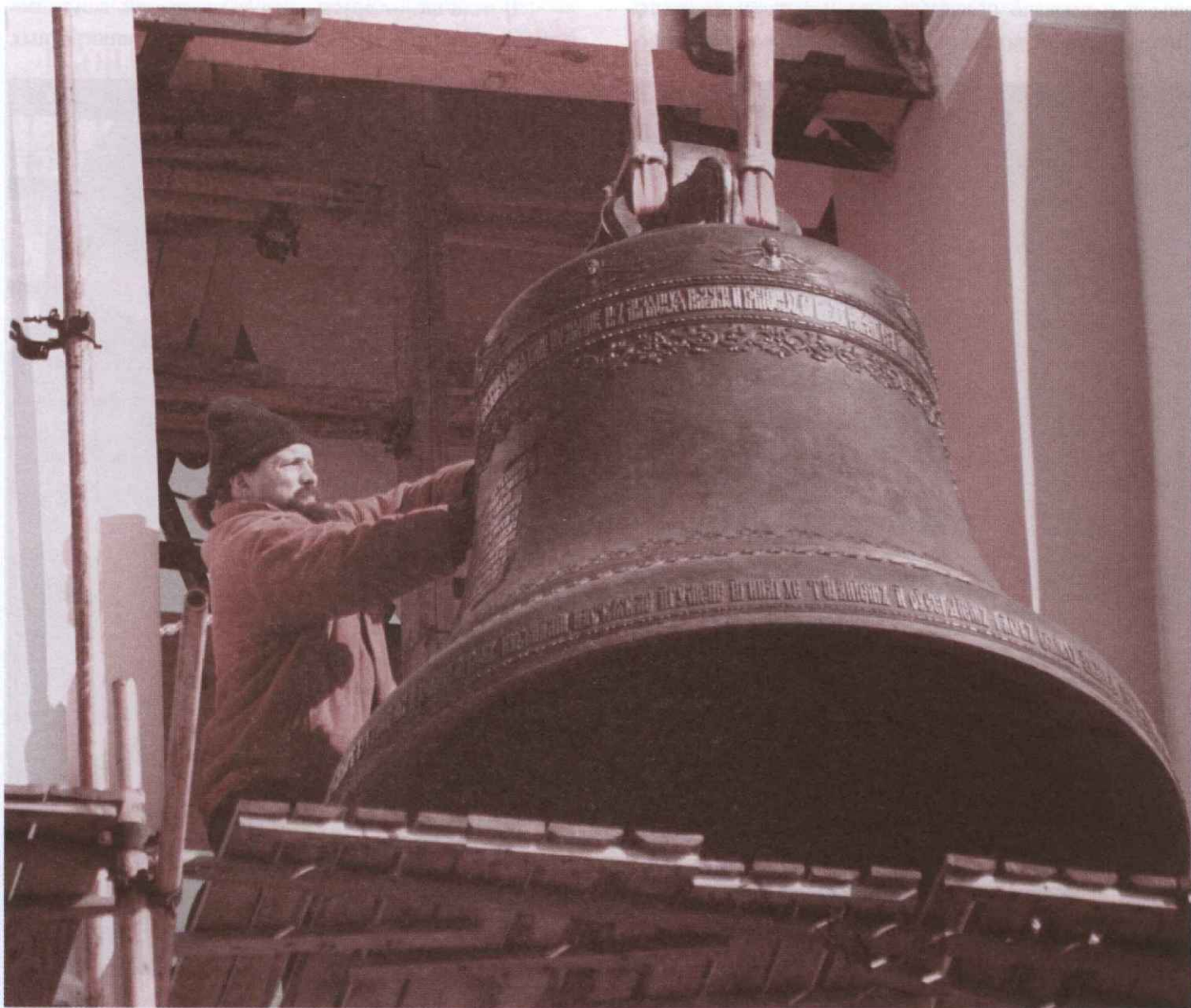
Завершающая удачная попытка установки самого большого колокола
