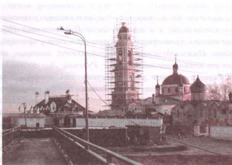
Реставрация и строительство на территории храма Архангела Михаила в 2004 году
